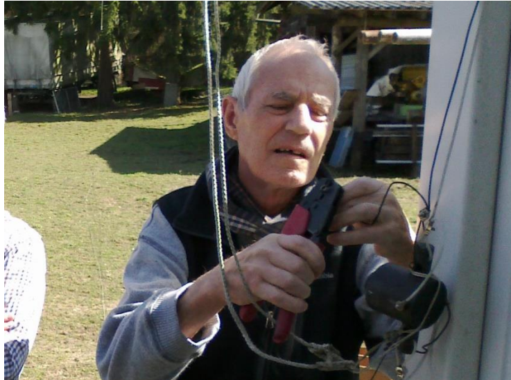
Walti beim Spleissen der Anschlüsse für die 80/160 m-Antenne unserer Klubstation
